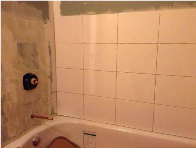
Vendredi soir Le nouveau mur commence a grandir
