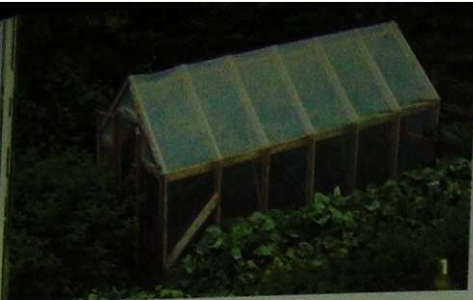
1. Serre de fabrication artisanale à ossature en bois recouverte d'un film de polyéthylène.
