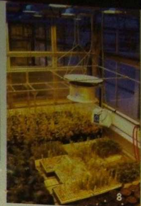
6. Lorsque la serre est de petite dimension, il est possible d'utiliser seulement un petit ventilateur pour y assurer un mouvement d'air. Une chaufferette munie d'un ventilateur peut remplacer l'effet du ventilateur de recirculation dans ce cas.
