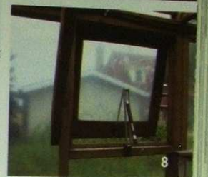
5. Panneau ouvrant latéral localisé dans le haut du mur.
